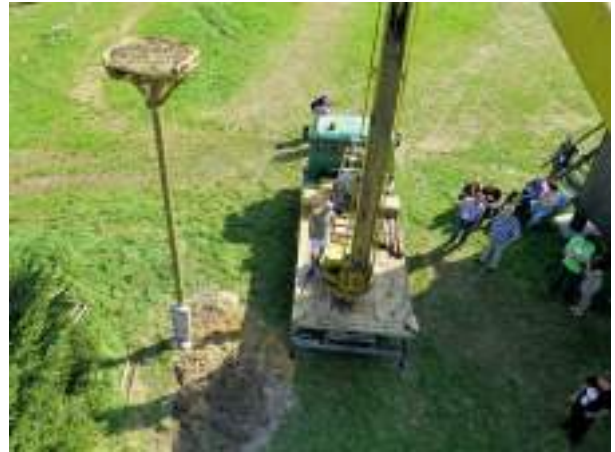
Рисунок 27. Процесс установки платформы завершен.
