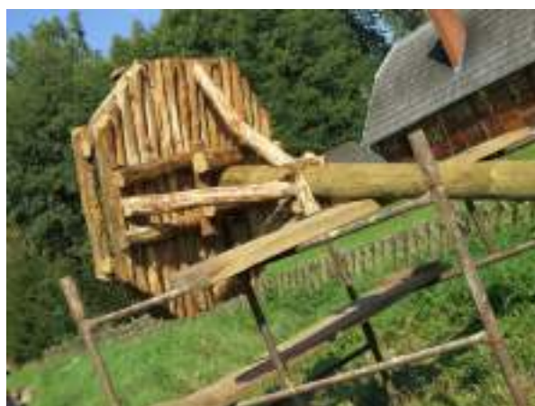
Рисунок 11. Деревянные детали платформы прочно соединены крупными гвоздями.
