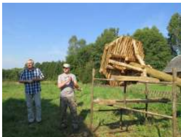
Рисунок 12. Для облегчения подъема на высоту платформу можно приподнять над землей.
