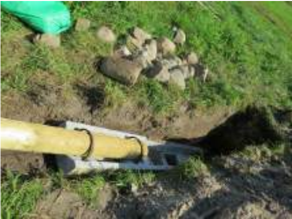
Рисунок 15. Яма для платформы. Камни для укрепления основания желательно заготовить заранее.
